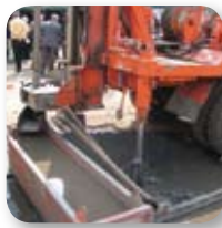
Die Wärmekollektoren werden bis zu 100 m tief im Erdreich installiert.
