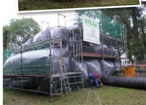
Holzschädlingsbekämpfung mit 55 Grad heißer Luft für die Stellmacherei Langenrehm
